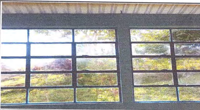
Foto 3: se cambiaron algunas ventanas que se encontraban en mal estado
