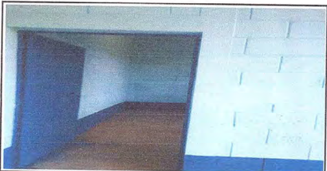
Foto 5: se realizó cambio de techo de la dirección y se pintó las paredes
