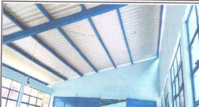
Foto 2: se cambiaron las láminas y se pintaron las costaneras que se encontraban en mal estado
