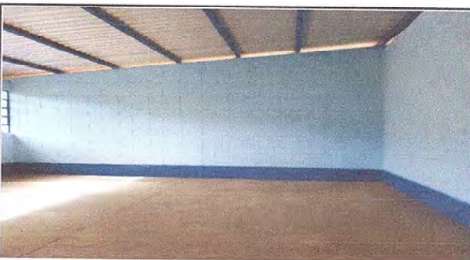
Foto 4: se mejoro bastante la estructura del techo del establecimiento completo
